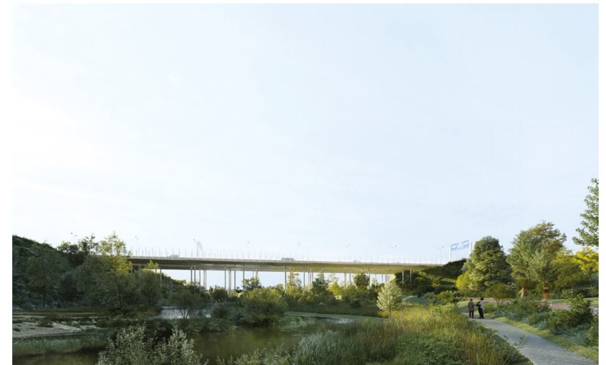
Réaménagement R0 - Zaventem
