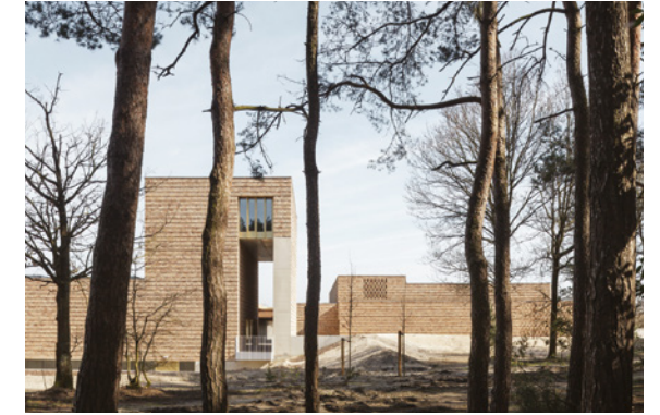
Crématorium Stuijduin - Lommel
