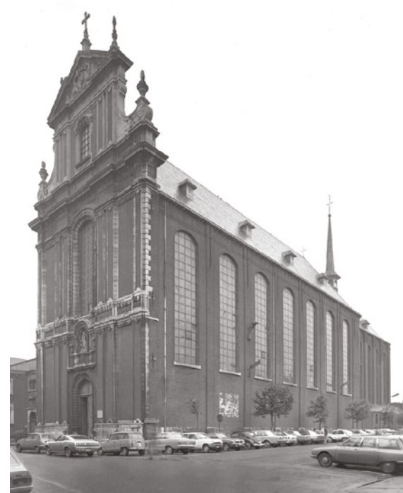
Étude sur la réaffectation du site Minderbroeder - Saint-Trond
